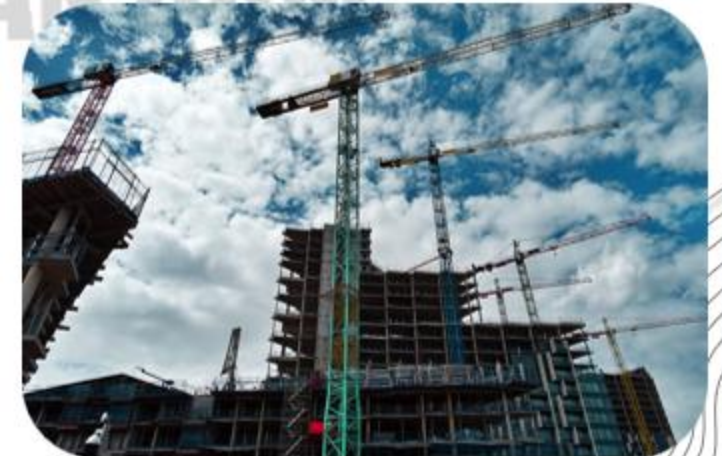
Site dust suppression
